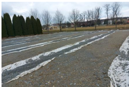
Správně provedené drenážní rýhy ve stabilizační vrstvě drceného kameniva FR.0-63mm (bez použití celoplošné netkané geotextilie 400g/m 2 )
