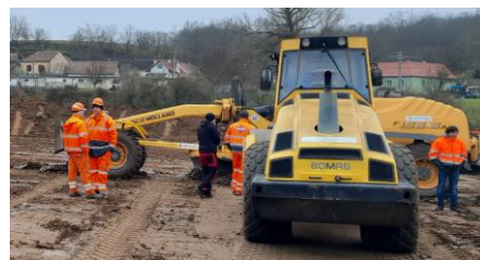
Případně možno použít vhodnou těžší techniku s vhodnými pneumatikami a velkými poloměry otáčení
